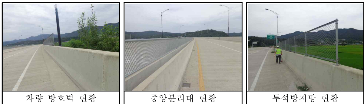
【그림 3.5】 방호벽/중앙분리대 현황
