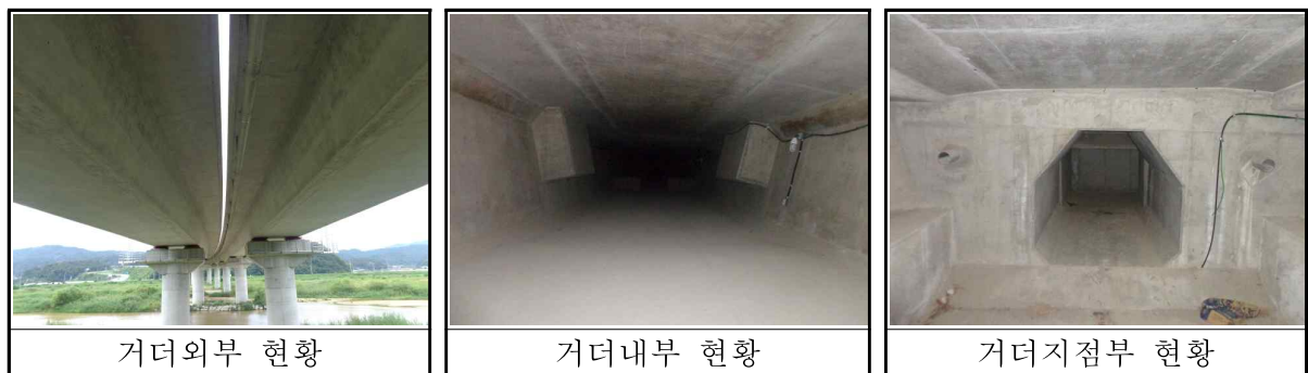
【그림 3.12】 P.S.C Box Girder 현황
