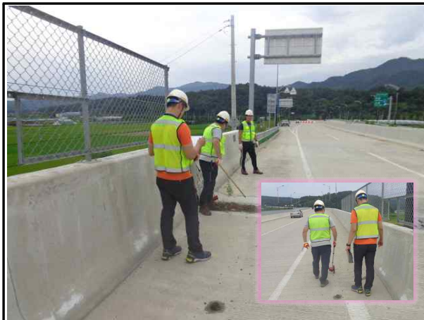
교량상부 외관조사 (3인 1조, 도보조사: 신호수 배치)
