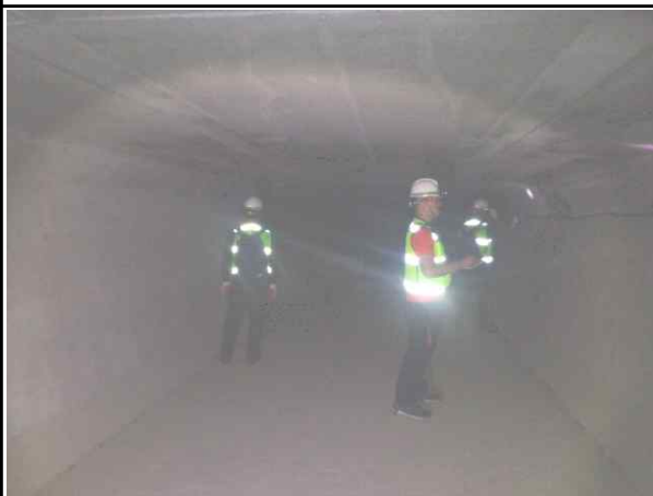
거터내부 외관조사(4인 1조)
