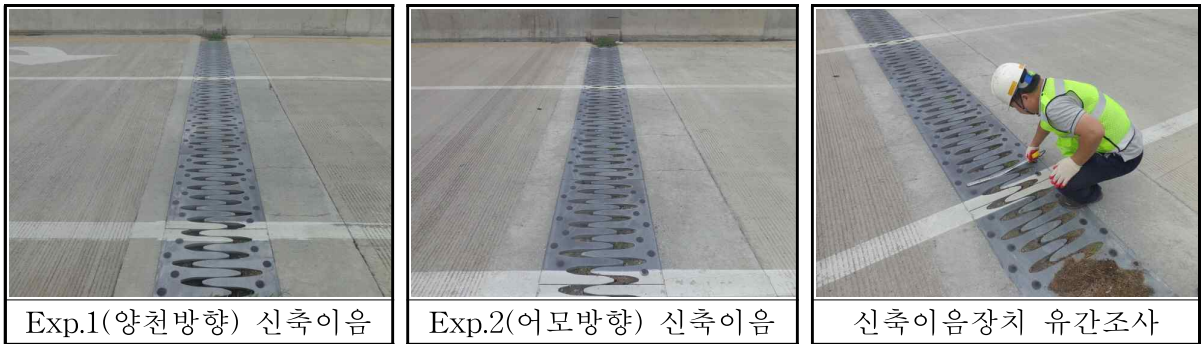
【그림 3.22】 신축이음장치 현황 및 외관조사
