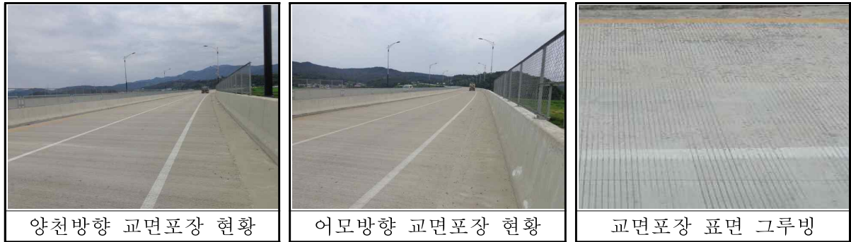
【그림 3.3】 교면포장 현황
