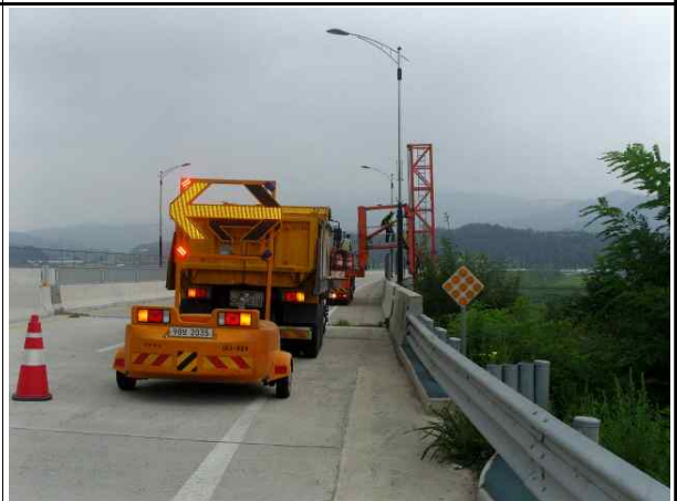
차선통제 시 작업장 안전 확보 (싸인보드 및 신호수 배치)
